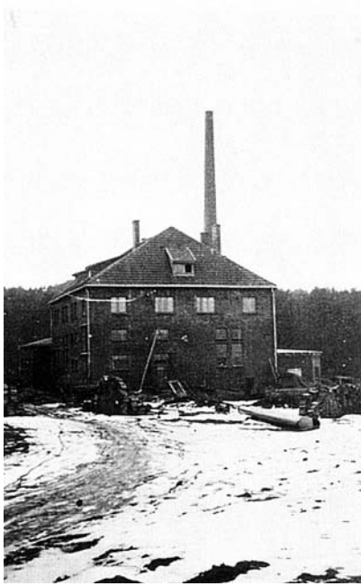
Mein Geburtshaus, die Brennerei in Priddargen, erbaut 1935
